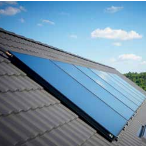
Pločasti kolektori montirani na kosi krov
